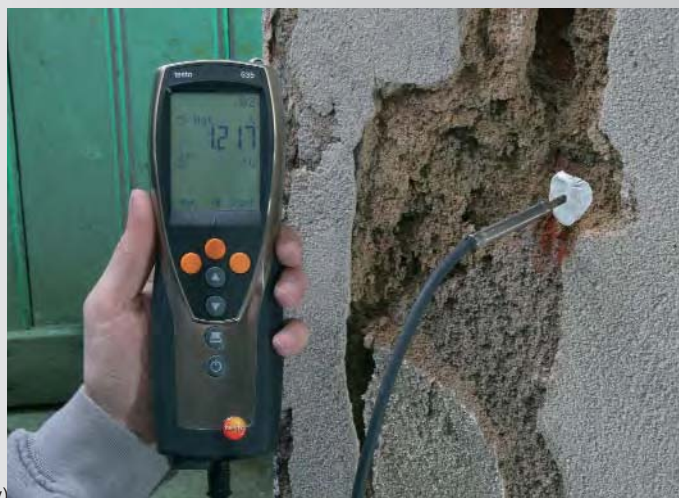
Zjišťování vlhkosti zdiva na bázi rovnovážné vlhkosti vzduchu
