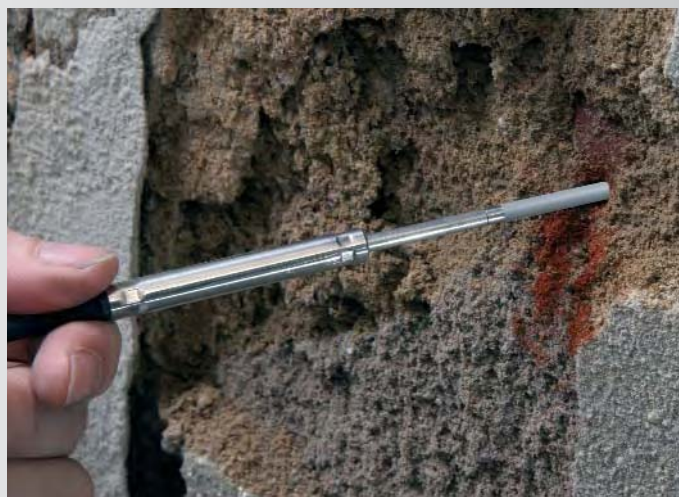
Vsunutí vlhkostní sondy s teflonovou krytkou do vyvrtané díry
