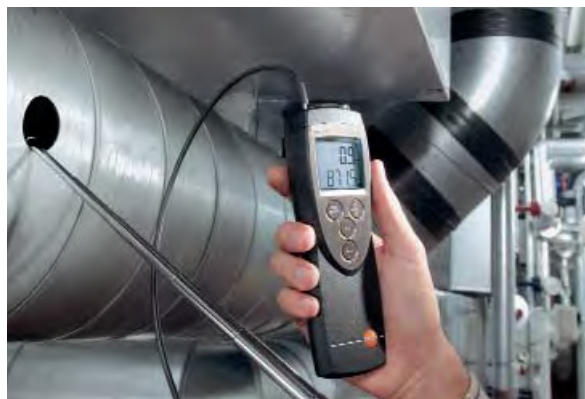
testo 425 při zjišťování objemového průtoku odsávaného vzduchu
