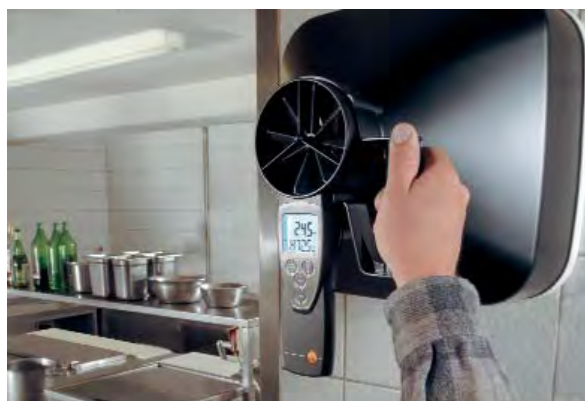
testo 417 při kontrole odsávaného vzduchu na vestavěném ventilátoru
